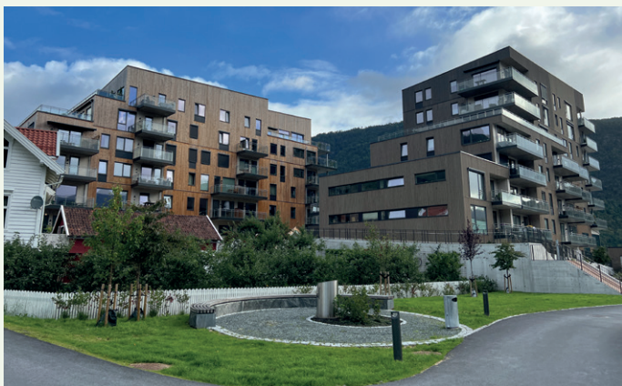
Prosjektet er bygget i en totalentreprise av Veidekke Entreprenør, og byggherre er Lerum Brygge AS, med Nordr og flere investorer på eiersiden.
