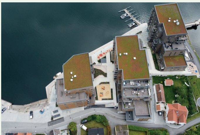
Takene har sedumdekke.
