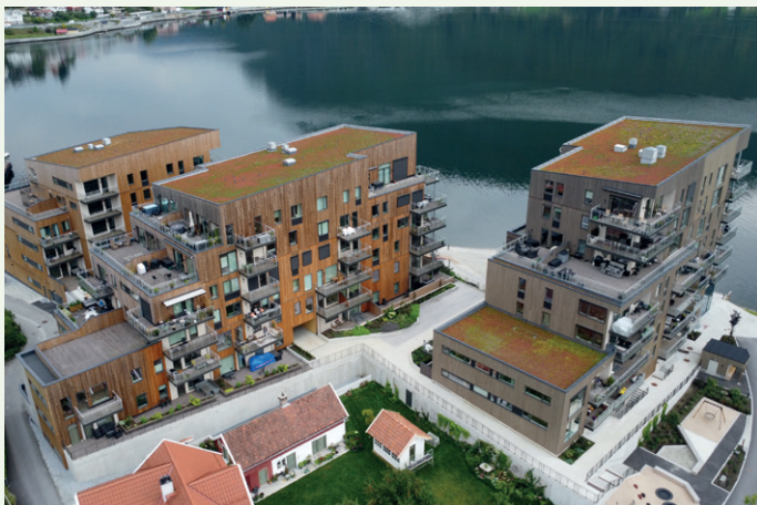
Storprosjektet Lerum Bygge i Sogndal er nå fullført.
